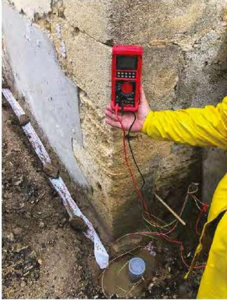
**Fig. 6 :** Raccordement de l'anneau correcteur avec l'édifice et mesures de vérification
