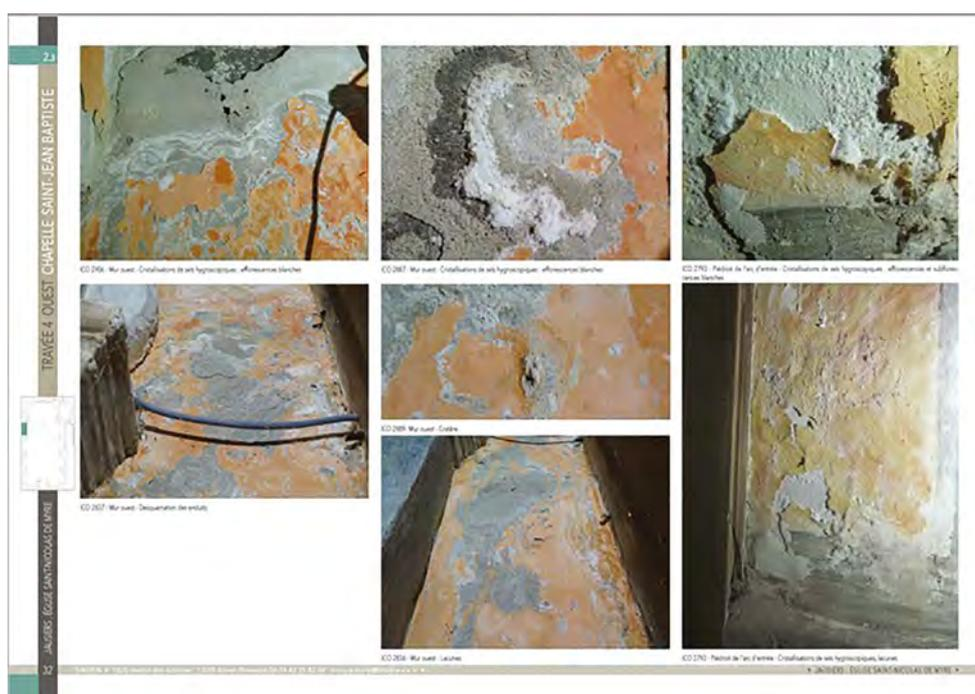
**Fig. 8 :** Diagnostic (2016) – relevés de figures d'altération active dues aux sels hygroscopiques © Agence M. Trubert
